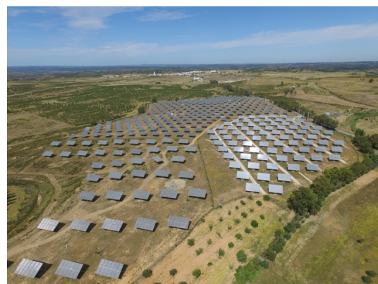
Flygfoto över solcellsanläggningen i södra Portugal
